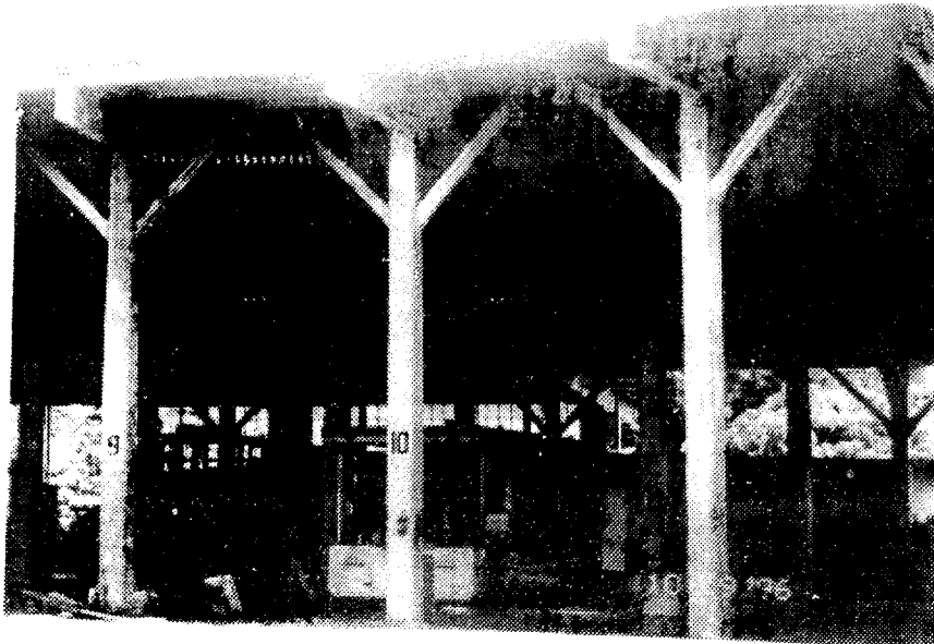
ROUND HOUSE PARA REPARACIÓN
